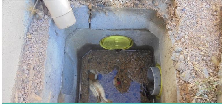
Exemple de descentes de chéneaux avec décanteur
